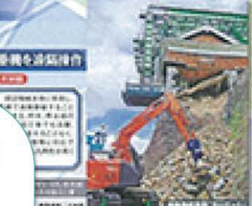
建設現場での作業
